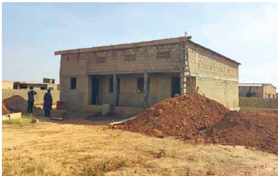
costruzione e allestimento di sette aule in Burkina Faso
