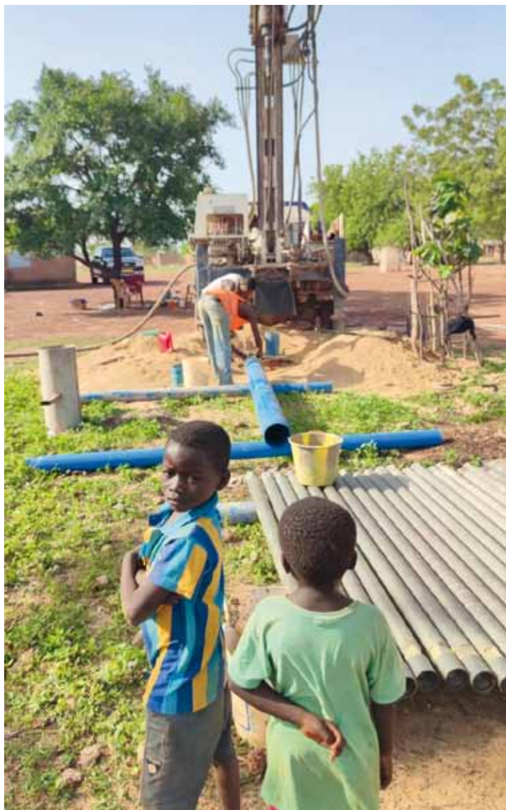
realizzazione di tre pozzi e relative infrastrutture in Burkina Faso
