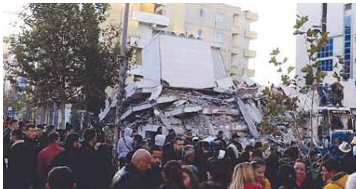
a fianco palazzi lesionati dal sisma a Durazzo
